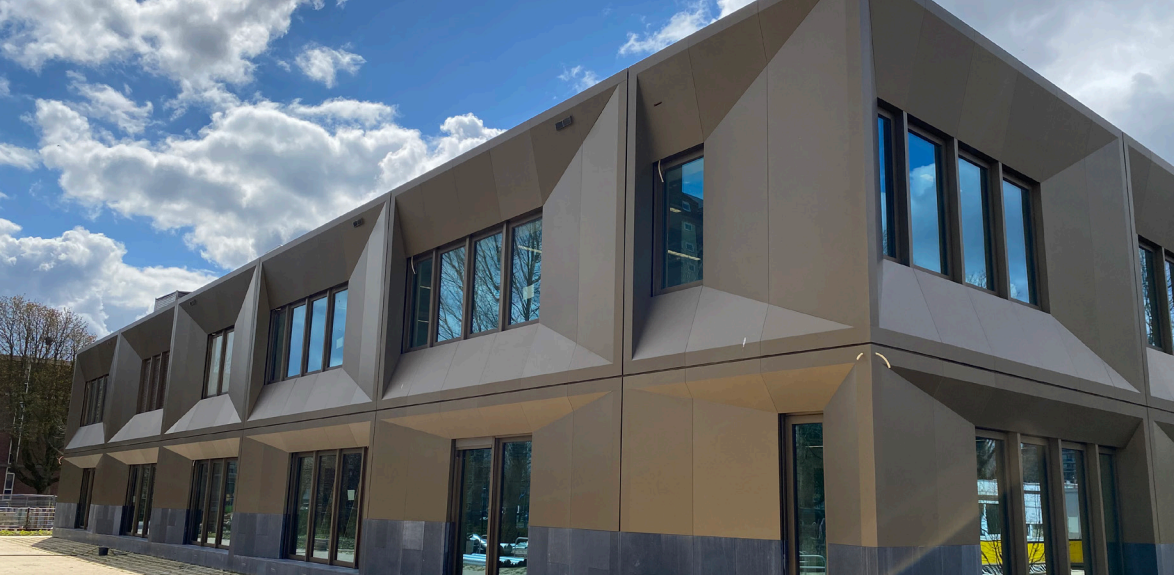
Beeld: © Compal Composites Foto van de Alucobond-gevel van het Praktijk College in Rotterdam
